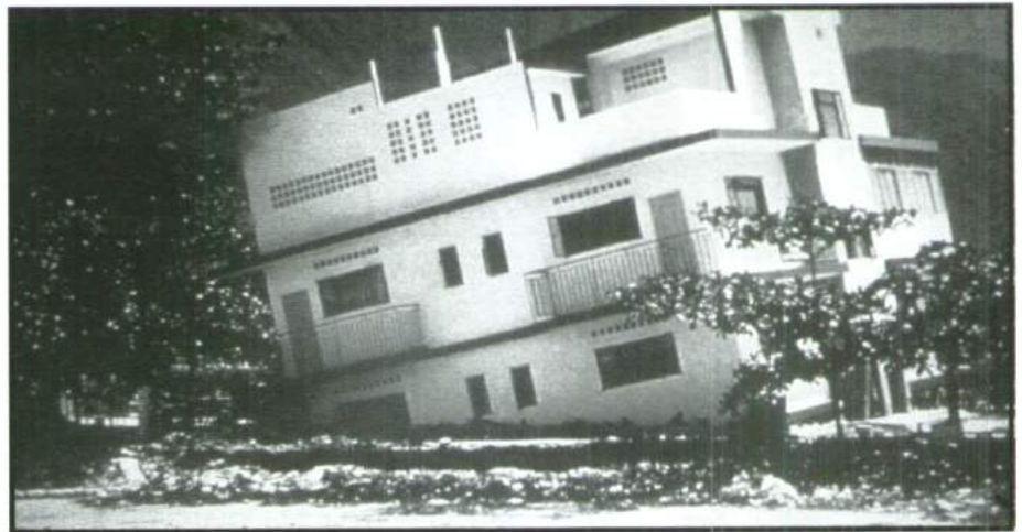
Figura 26: Daños provocados en una residencia por un terremoto.
