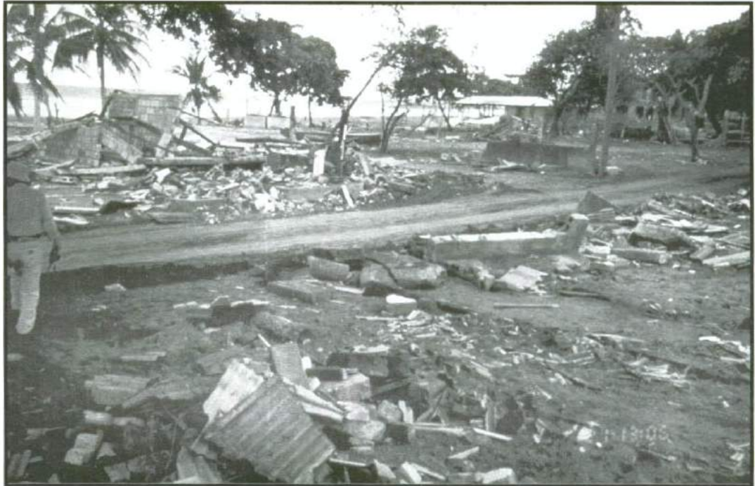
Figura 20: Daños provocados por un maremoto.
