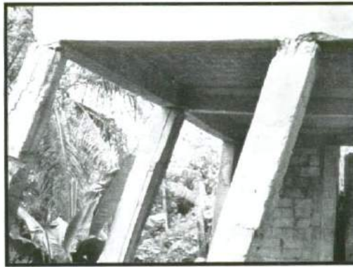
Figura 39: El movimiento provocado por las ondas sísmicas puede debilitar y mover las columnas que sostienen una residencia.
