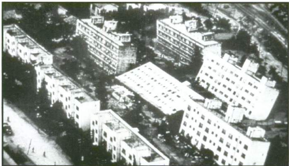
Figura 25: Colapso de edificios provocados por el efecto de licuación.
