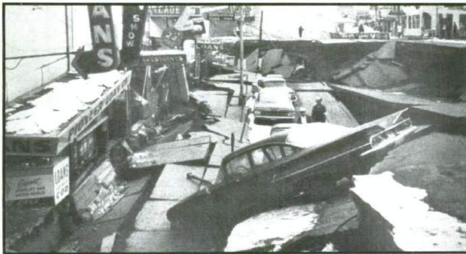
Figura 31: Daños por el colapso de una calle.
