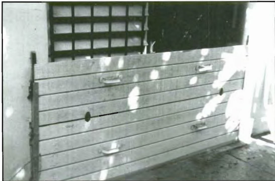
Figura 76: Otra compuerta de madera ya instalada.
