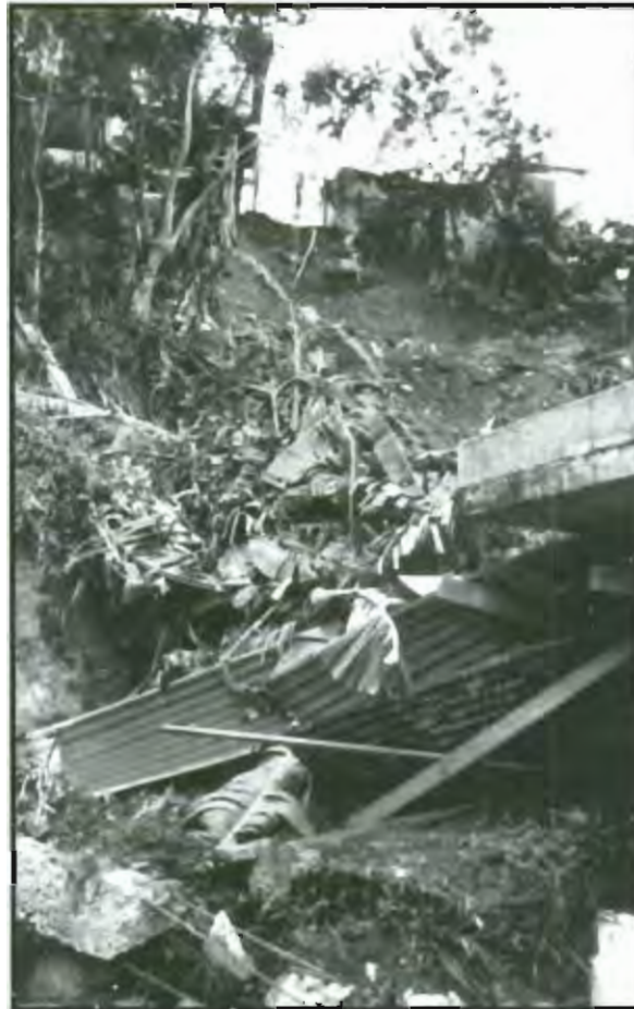
Figura 36: Vegetación y escombros llegan al techo de una casa en la parte baja de la ladera.
