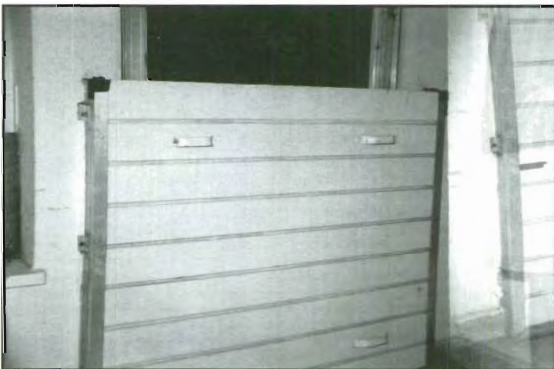
Figura 74: Compuerta de madera instalada.
