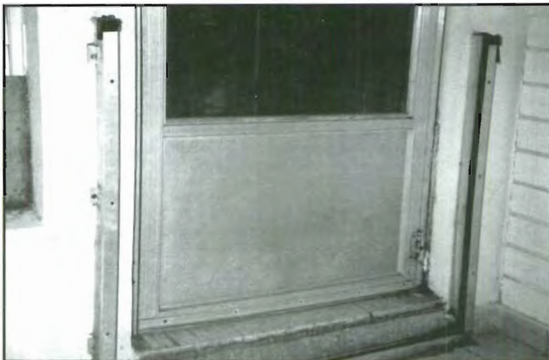
Figura 73: Canal para instalar compuerta de madera.
