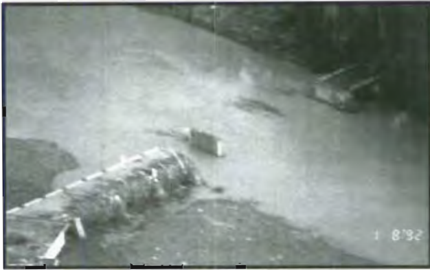
Figura 10: La fuerza del agua destruyó puente.
