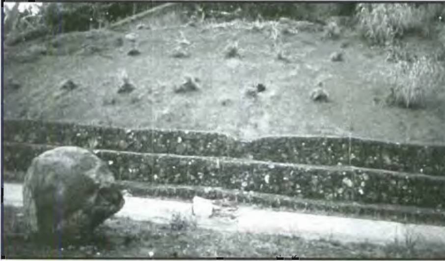
Figura 39: Pared de piedra sostiene el movimiento de tierra y piedras de la pendiente.
