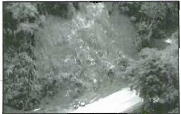
Figura 32: Derrumbe en la ladera de montaña.
