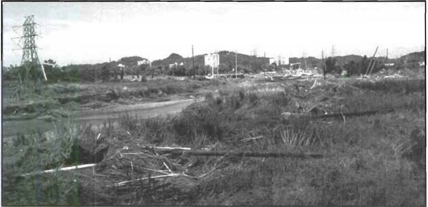
Figura 15: Daños en la infraestructura en el Río Bayamón por el huracán Hortensa (1996).
