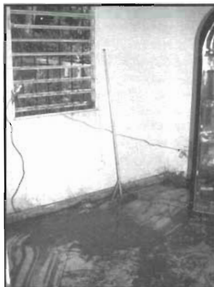
Figura 59: Agua con lodo llega al interior de esta residencia.
