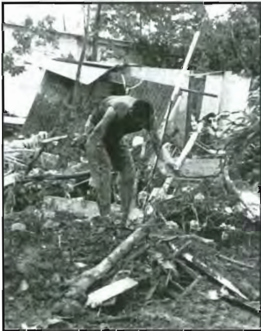
Figura 41: Es una tarea ardua el proceso de limpieza después de una inundación o derrumbe.
