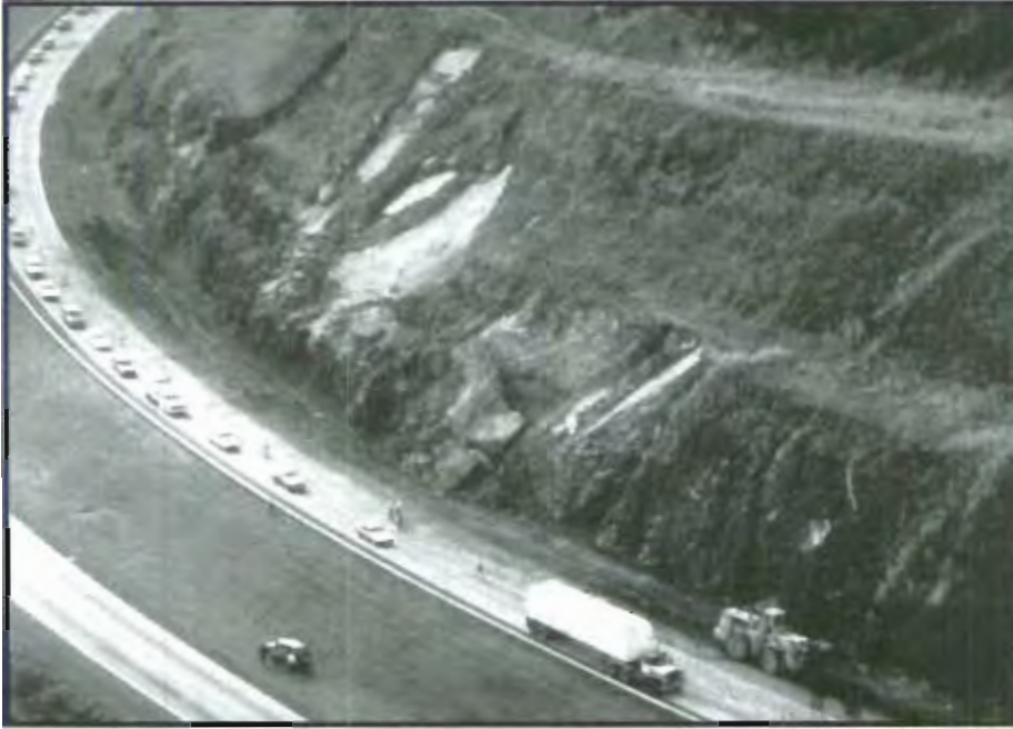
Figura 37: Los derrumbes pueden afectar las vías de tránsito.
