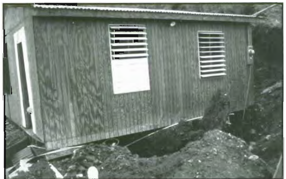
Figura 34: Residencia afectada por un derrumbe.
