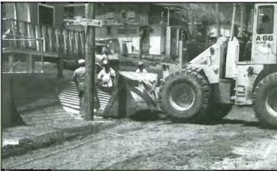
Figura 61: Limpieza de escombros tras la inundación.
