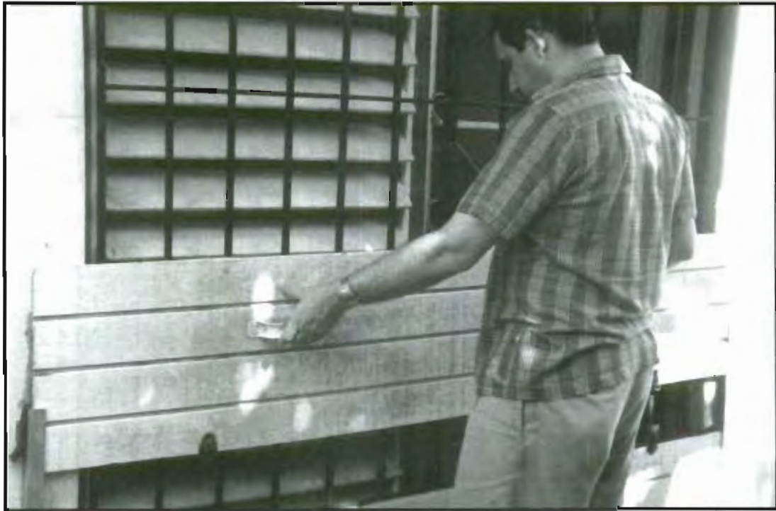
Figura 75: Instalación de otra compuerta de madera contra inundaciones.
