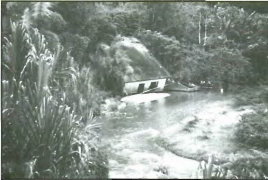
Figura 38: Casa desplomada hacia el río.
