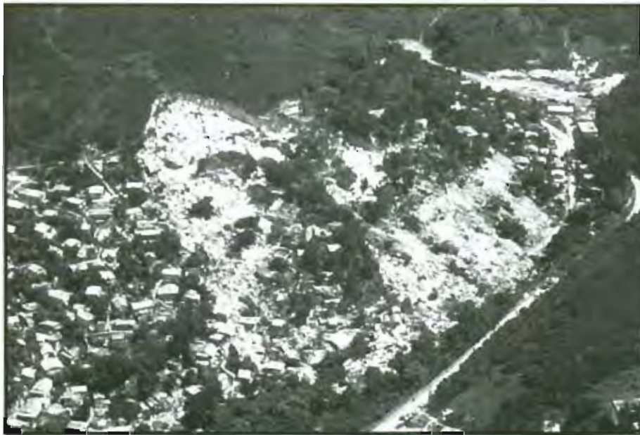
Figura 20: Vista aérea del derrumbe ocurrido en el Barrio Mameyes (1985).
