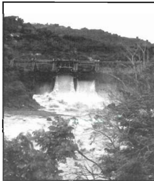
Figura 28: Vista de dos compuertas abiertas de la Represa Carraízo.
