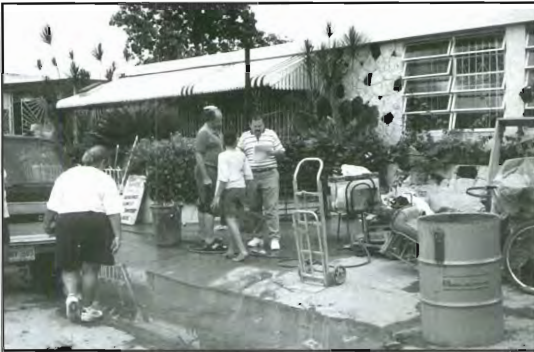
Figura 2: Daños producidos por el huracán Hortense en Bayamón (1996).
